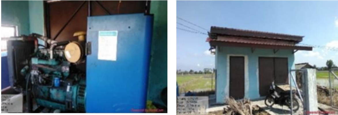
Gambar 2. Kondisi Sumur pada Rumah Pompa SBE 19
