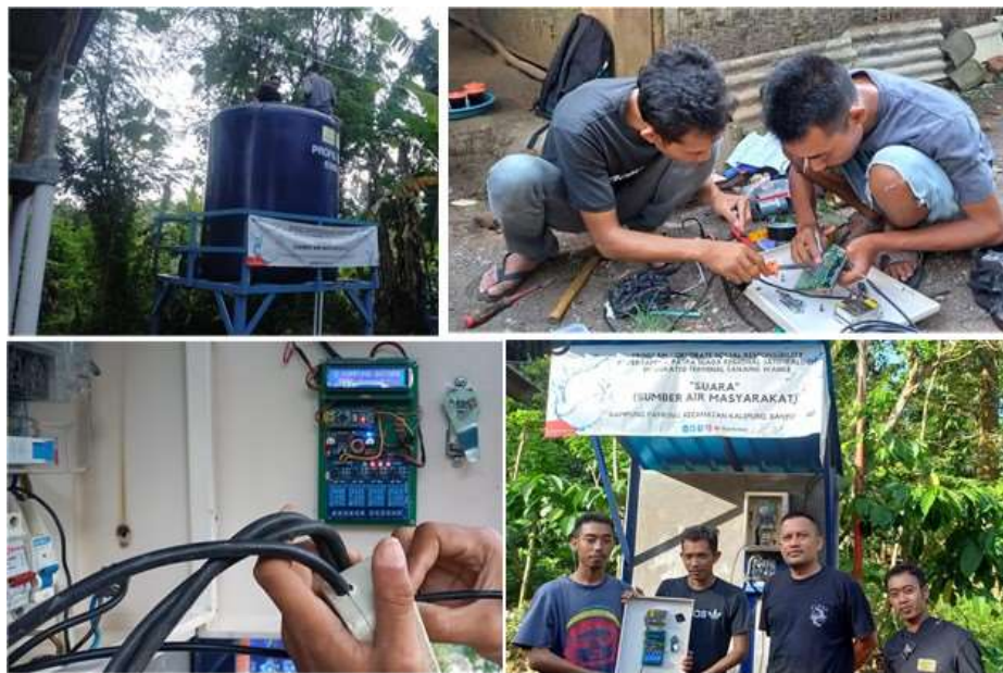
Gambar 7. Proses pemasangan dan uji coba teknologi
