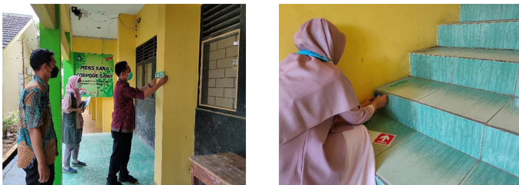
Gambar 2. Pemasangan tanda evakuasi pada Lorong kelas dan tangga
