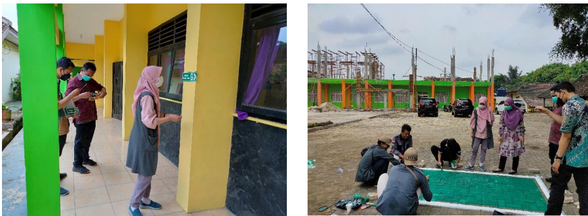
Gambar 4. Pemasangan Jalur evakuasi dan pembuatan tanda titik kumpul di SMK Negeri 1 Bandar Lampung
