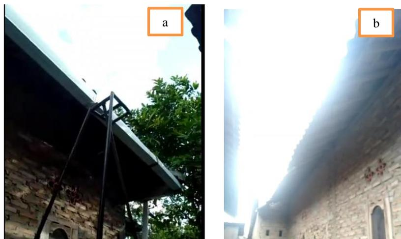
**Gambar 2.** Kondisi atap rumah sebelum dan setelah dipasang talang air, (a) Talang air yang sudah dipasang pada atap rumah, (b) Kondisi atap rumah yang sebelum terpasang talang air.
