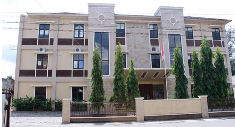
Gambar 1. Gedung Sekolah SMA TMI
